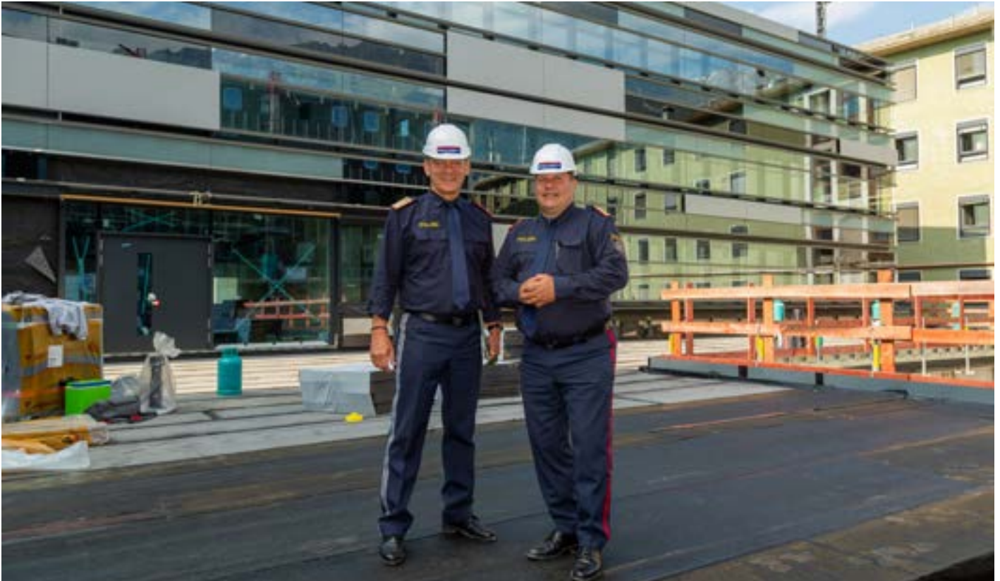
LPD Mag. Helmut Tomac führte Bundespolizeidirektor General Michael Takács durch die Baustelle des neuen Sicherheitszentrums.
